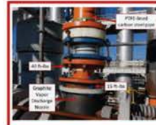
รูปที่ 1 ลักษณะของท่อ และแรงบิด (torque) ที่ถูกต้อง
